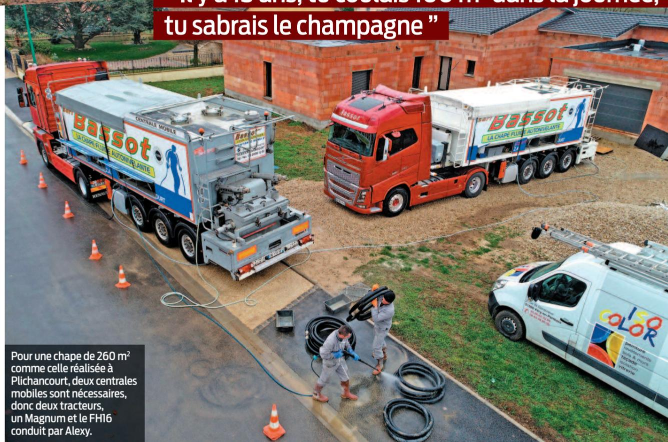
Pour une chape de 260 m<sup>2</sup> comme celle réalisée à Plichancourt, deux centrales mobiles sont nécessaires, donc deux tracteurs, un Magnum et le FH16 conduit par Alexy.
