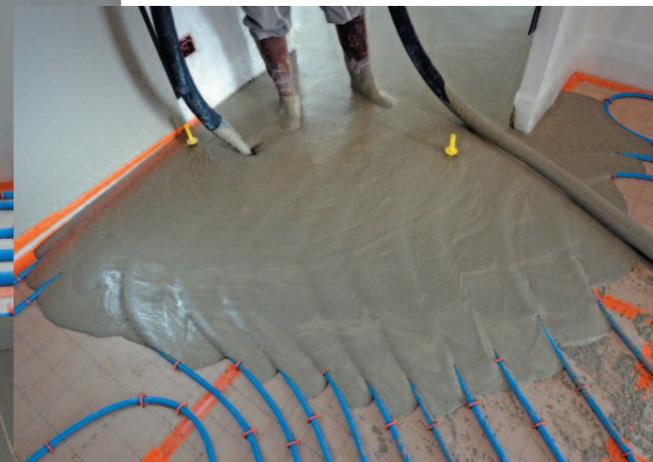
Le mortier est coulé. Achevée, la chape est séparée par un joint de dilatation entre deux pièces.
